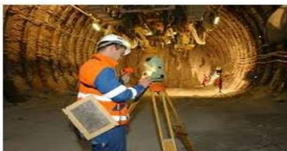
18 Сурет – Электронды тахеометрлермен жұмыс атқару: а- штативте орнатылған тахеометр; б- қазба төбесіне іліп қойған тахеометр.
